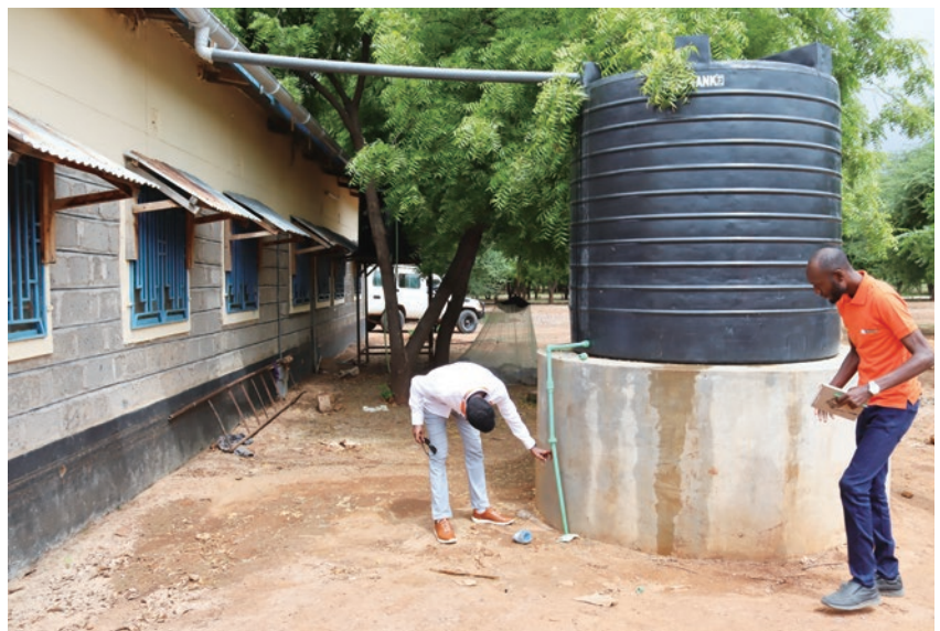
評估衛生機構現有 WASH 設施，以確定需要修復的部分。（圖為儲水設備）
