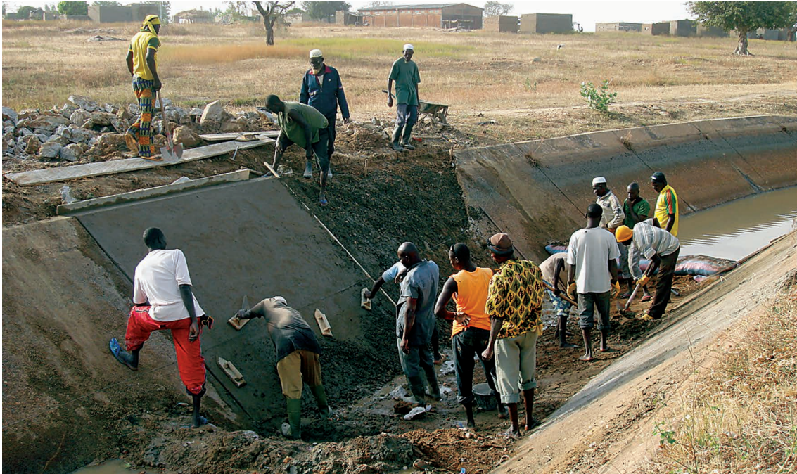
TaiwanICDF lleva a cabo el "Proyecto de asistencia técnica en Bagré (Burkina Faso)" para la realización de las obras de mantenimiento en la cara interior de la acequia principal de los campos cultivos en Bagré.
