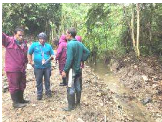
水源取水點勘查
