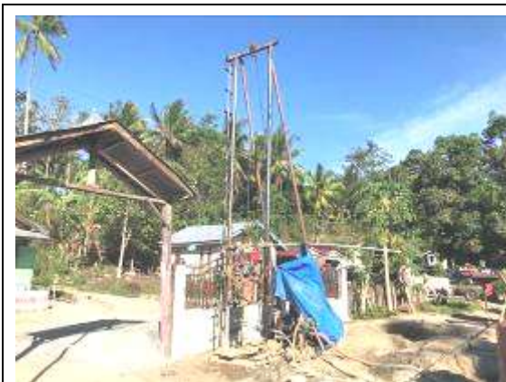
水源設施施工
