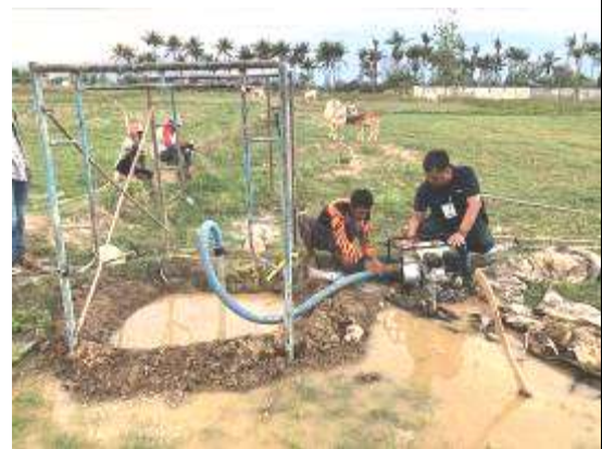
淺水井修繕(移位)工程施工
