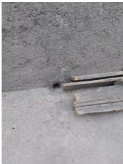
屋頂雨水的流出孔 集
