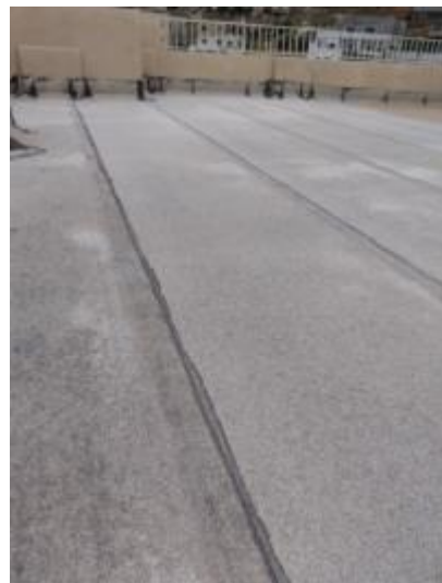
屋頂表面溝槽以利雨水收
