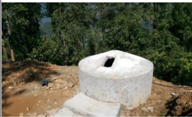
圖 1. 衛生站之胎盤掩埋坑:將產婦分娩後之胎盤丟入坑裡再用土掩埋。
