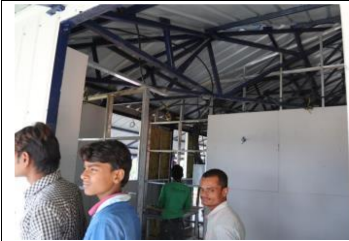
圖 3. Gairimudi 衛生站內部，可見內部架構及隔間皆已完成。
