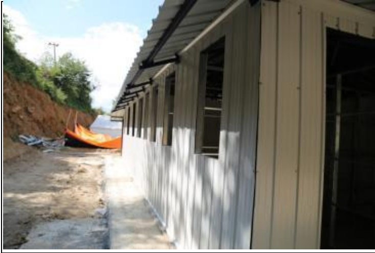
圖 9. Gairimudi 衛生站後方鄰 接斜坡
