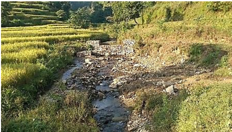
本計畫協助修復之灌溉系統
