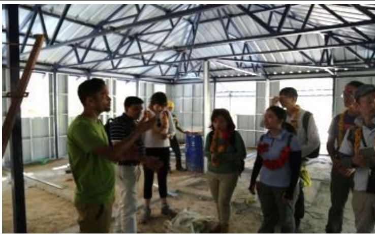
圖 7. Phulpingkot 衛生站內部，可見內部隔間、牆板皆尚未安裝。
