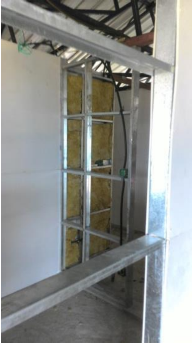
圖三：統一規格的衛生站，梁柱是鋼，牆壁是輕鋼架，牆壁版是矽酸鈣板。地板是磨石子地板。
