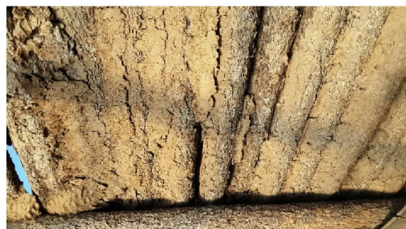
冬季圈養乳牛舍 1 土牆 (原木 + 牛糞混泥)
