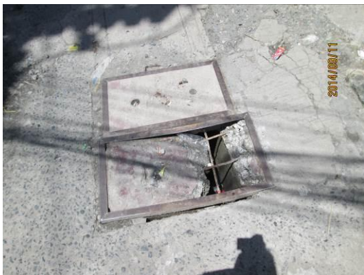
圖 9. 排水系統失修且危及道路安全，地勢低窪區長年淹水
