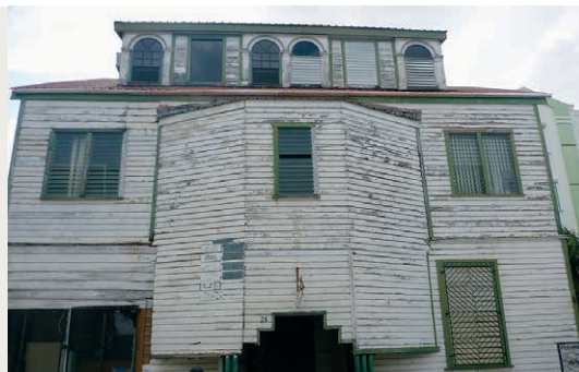
Muchos edificios históricos de la Ciudad de Belice están en urgente necesidad de reparación y restauración.
