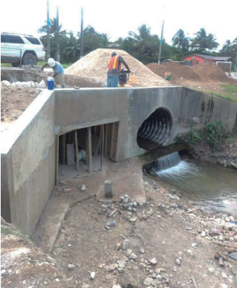
「貝里斯城市韌性防災計畫」全方位強化友邦調適極端氣候的能力，圖為技術人員實地安裝氣象感測設備與水利防汛工程施工
