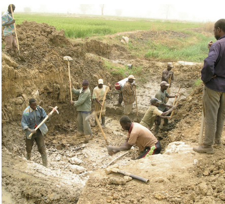
巴格雷墾區支渠開挖
