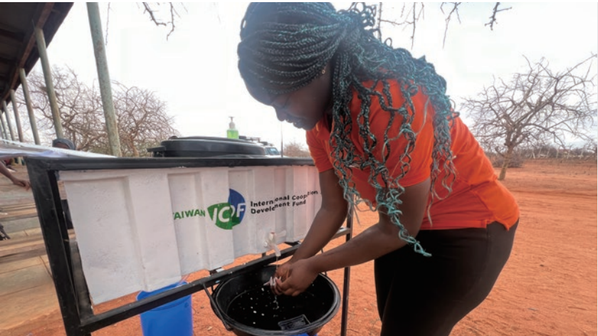
En el marco del proyecto “Mejoramiento del acceso al agua, saneamiento básico e higiene en diez establecimientos de salud para comunidades vulnerables en el condado de Garissa, Kenia”, el Fondo de Cooperación y Desarrollo Internacional de Taiwán (TaiwanICDF) brindó asistencia mediante la instalación de estaciones de lavado de manos, a fin de garantizar una adecuada higiene de manos tanto para el personal médico como para los pacientes.
