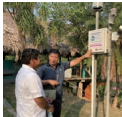
El Proyecto instaló estaciones de monitoreo meteorológico e hidrológico que mejorará la precisión en la alerta temprana de inundaciones.
