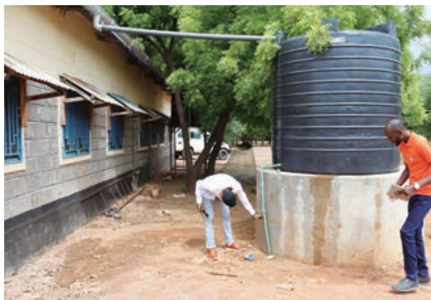
Evaluación de las instalaciones WASH que actualmente existen en las instituciones de salud, para identificar las partes que requieren reparación. (imagen de los equipos de almacenaje del agua)
