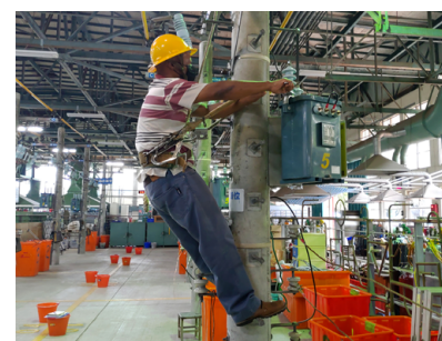
Participantes en el curso avanzado de cableado eléctrico.
