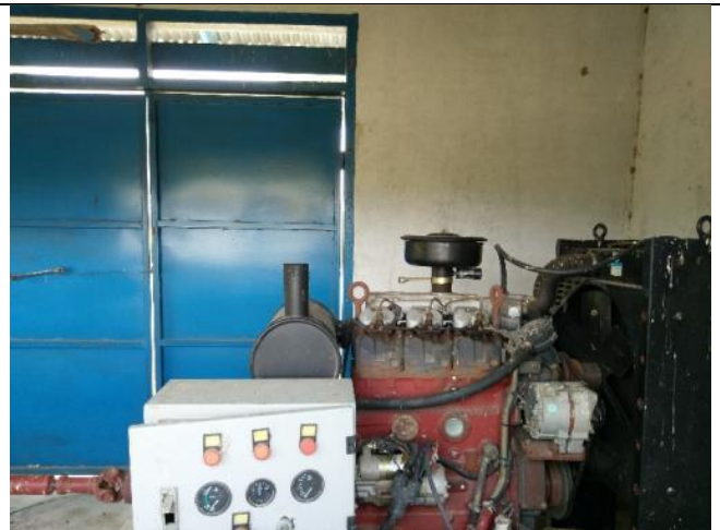
Sidera 村機房為採用柴油引擎做為抽水動力，抽水深度為 117 公尺，抽水量每秒 23.20 公升，抽水後，將地下水送到村口蓄水池儲存。
