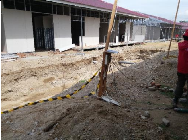
施工中之化糞池
