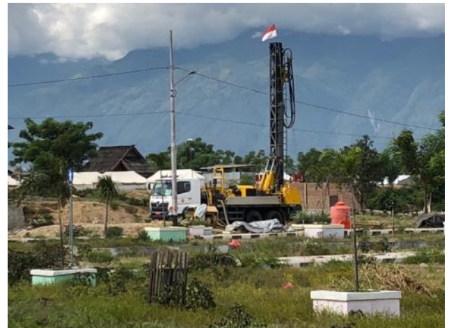
施工中之鑽井工程(井深 80 公尺)
