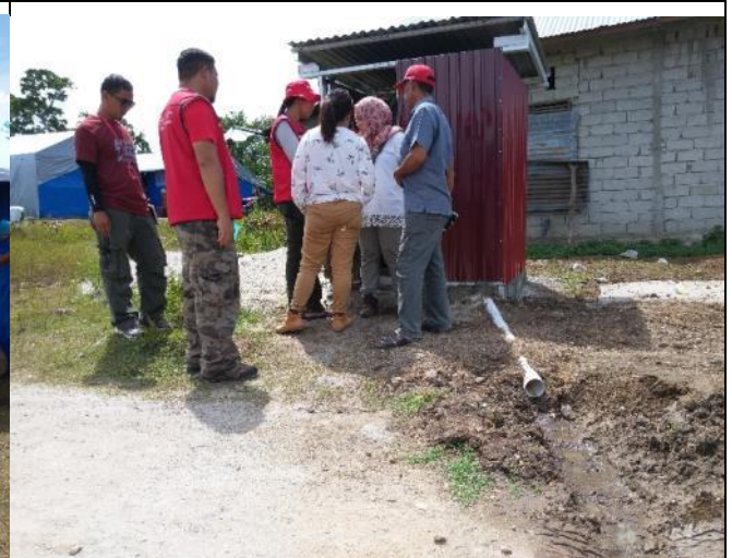
Loru 村公廁外觀，洗完手後之廢水直接排入路面，建議改善排水系統
