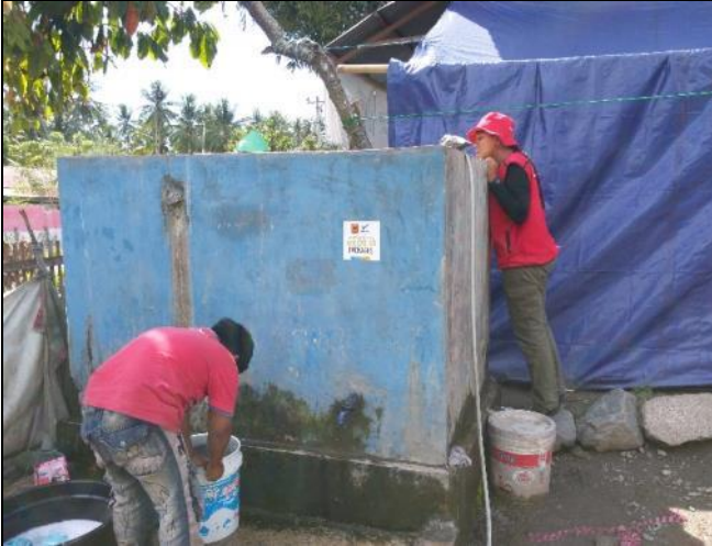
社區儲水槽外觀，旁邊為入水管。
